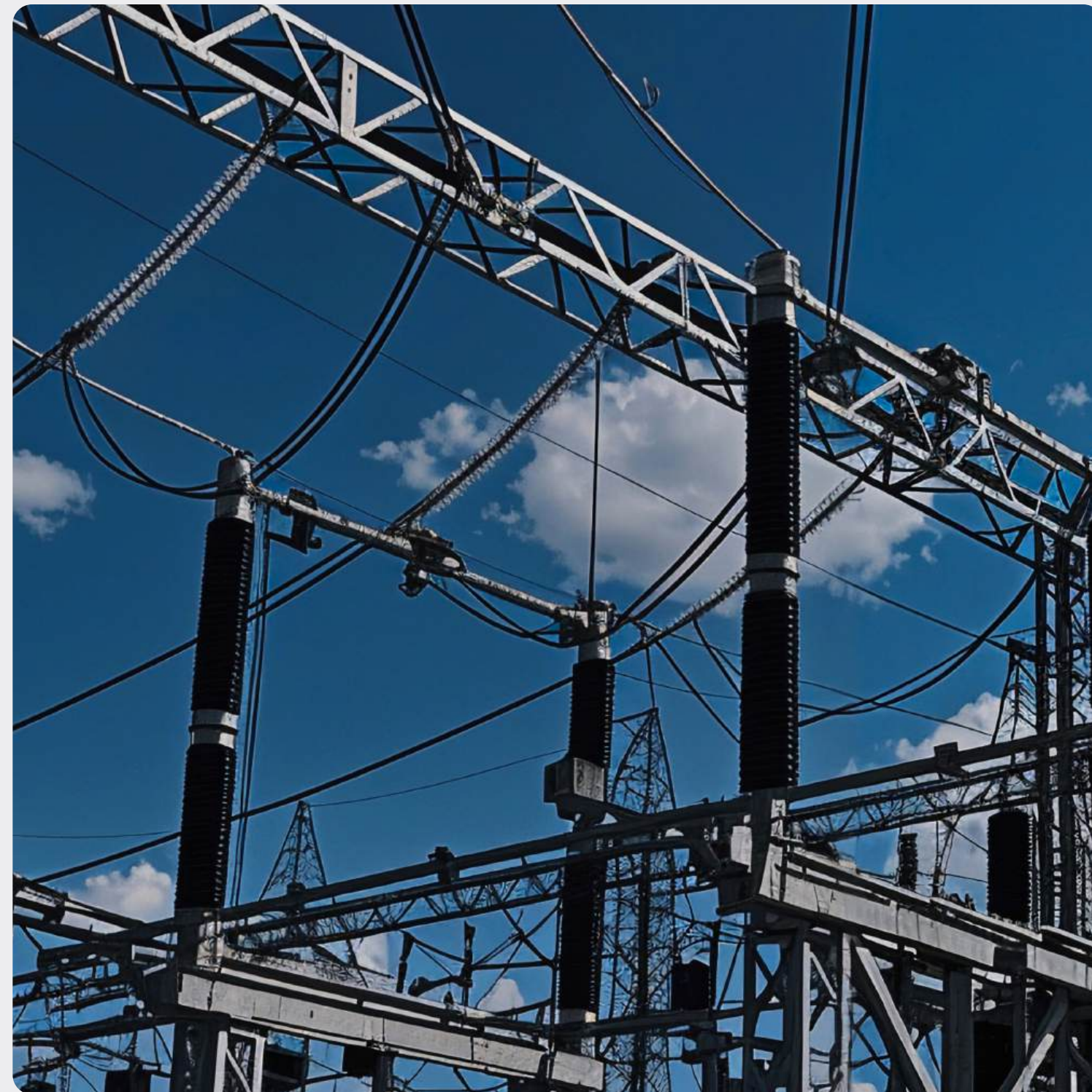
СТДМ-Э - Система технического диагностирования и мониторинга электроустановок
